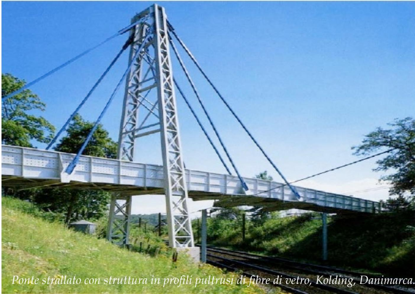
*Ponte strallato con struttura in profili pultrusi di fibre di vetro, Kolding, Danimarca.*
