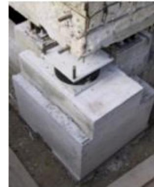
Fase 6: Messa in opera dell'armatura e loro inghisaggio, messa in opera dell'isolatore sismico, getto della base superiore e della trave
