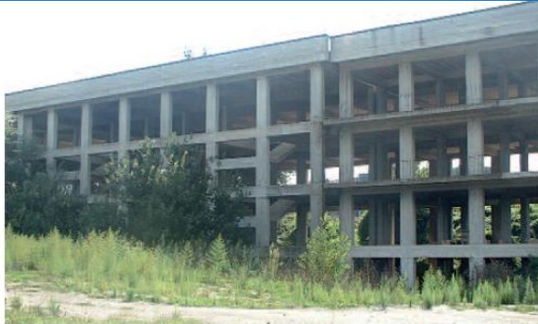
**Fig. 3.9.1: Vista di una struttura della città ospedaliera di Avellino in fase precedente all'intervento di isolamento sismico**
