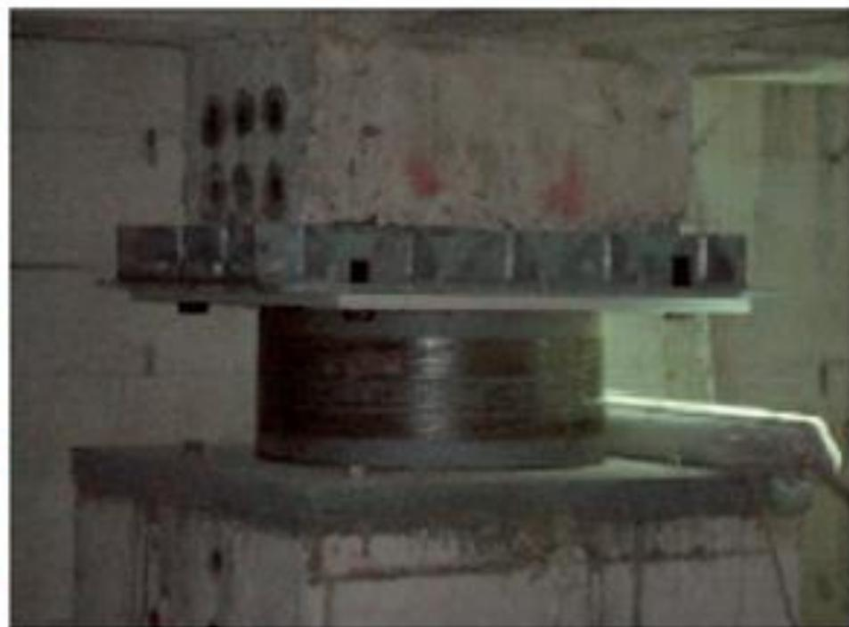
Foto: Fase di installazione dei dispositivi di isolamento
