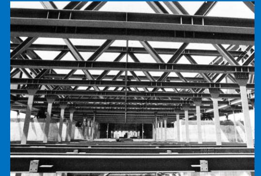
Solai sostenuti da tiranti in acciaio e collegate alle travi reticolari trasversali
