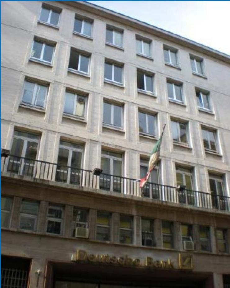
Il fabbricato in esame, sede della Deutsche Bank in via S. Brigida, rappresenta uno dei primi esempi di edifici multipiano con struttura in acciaio realizzati in Italia meridionale.
