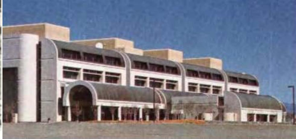
Il William Clyton Building di Wellington (NZ), del 1981, e' il primo edificio ad essere stato progettato con isolamento sismico alla base attraverso isolatori in gomma piombo (LRB).
