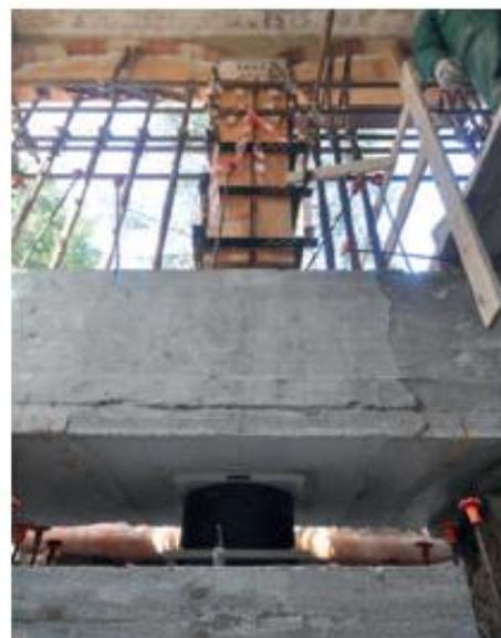
Foto 3: Vista di un isolatore inserito al di sotto del portico
