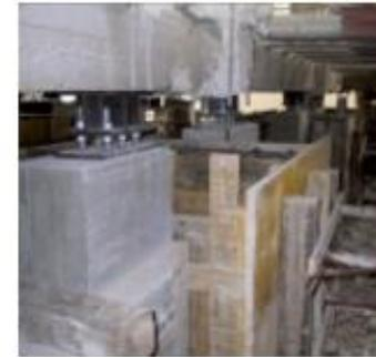
Fase 5: Messa in opera dell'armatura e loro inghisaggio, messa in opera dima per isolatore sismico, getto della base inferiore
