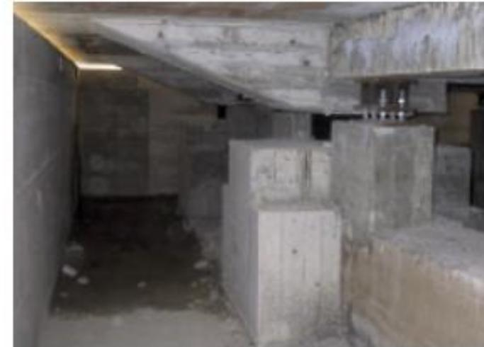
**Fase 7: Spostamento dei dispositivi di puntellatura e loro fissaggio permanente alla trave di fondazione. Serraggio dei bulloni di regolazione lasciando 2mm di spazio tra la piastra superiore del dispositivo e la trave di piano**
