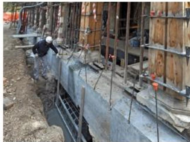
Foto 2: Fase di scavo e realizzazione dei baggioli di appoggio
