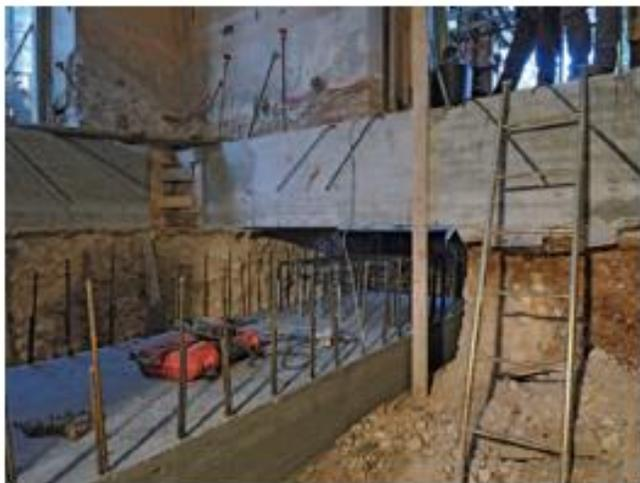
Foto 1: Vista della sottofondazione dell'edificio in muratura
