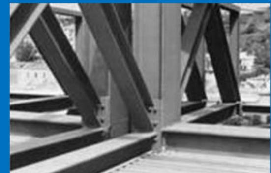
Collegamento della trave trasversale a quella principale (dettaglio)
