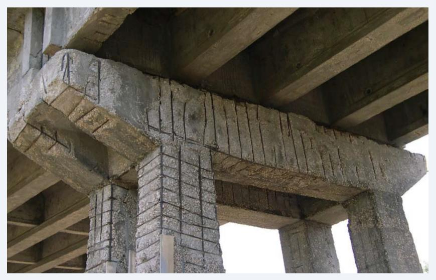
Esempio di degrado dovuto alla carbonatazione del cls ed al successivo processo di corrosione delle armature.
